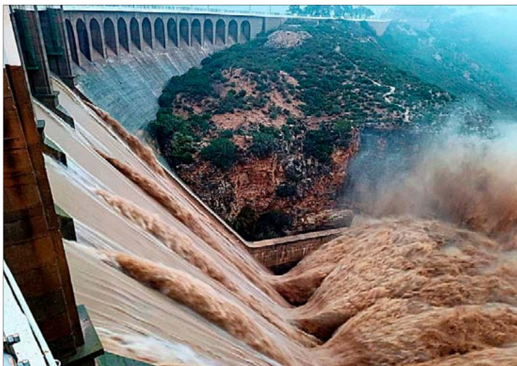
Imagen del dique de la presa de la Forata (Valencia), perteneciente a la Confederación Hidrográfica del Júcar. E. M.
