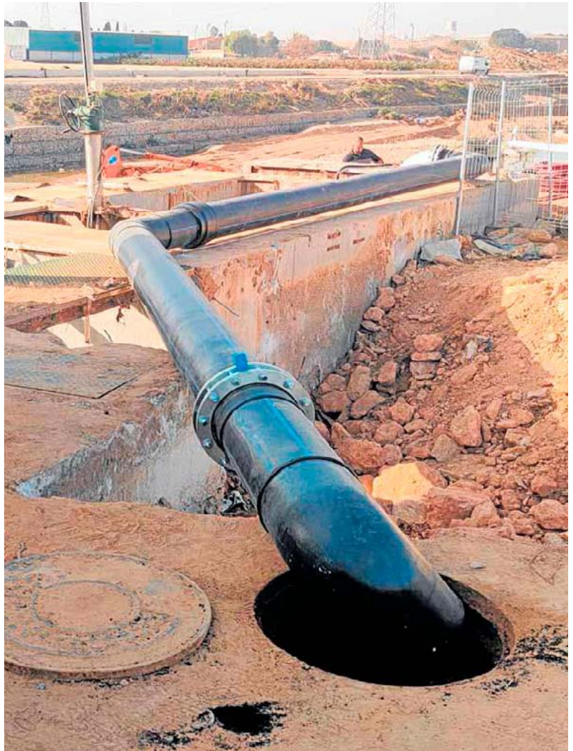
Tubería construida para conducir los vertidos a la planta de Pinedo. eva
